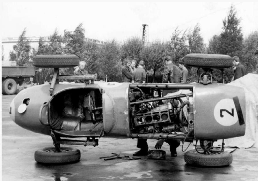
*Тенгиз Захаров ремонтирует свой гоночный автомобиль, легко обходясь без домкратов и подъемников. В таком ракурсе хорошо видна несимметричная компоновка автомобиля, выполненная по образцу шахвердовского ГА-22*
