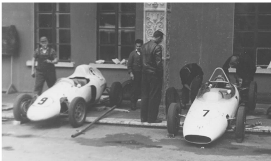
Польские автомобили формулы «Юниор»: под номером 9 – «Дельта-Юниор» Владислава Шульчевского, под номером 7 – «Рак-Юниор I» Ежи Янковского. На носу последнего виден рисунок рака – это была эмблема Янковского, которую он наносил на все сконструированные им автомобили (отсюда и их название) и даже на собственный шлем
