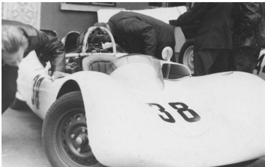
«Рак-1300». По обеим сторонам от места водителя видны воздухозаборники двух мотоциклетных двигателей воздушного охлаждения
